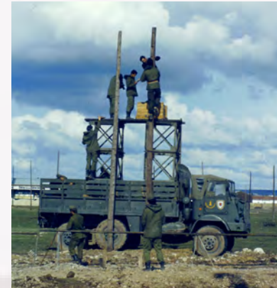
Instalación poste telegráfico Villafría
